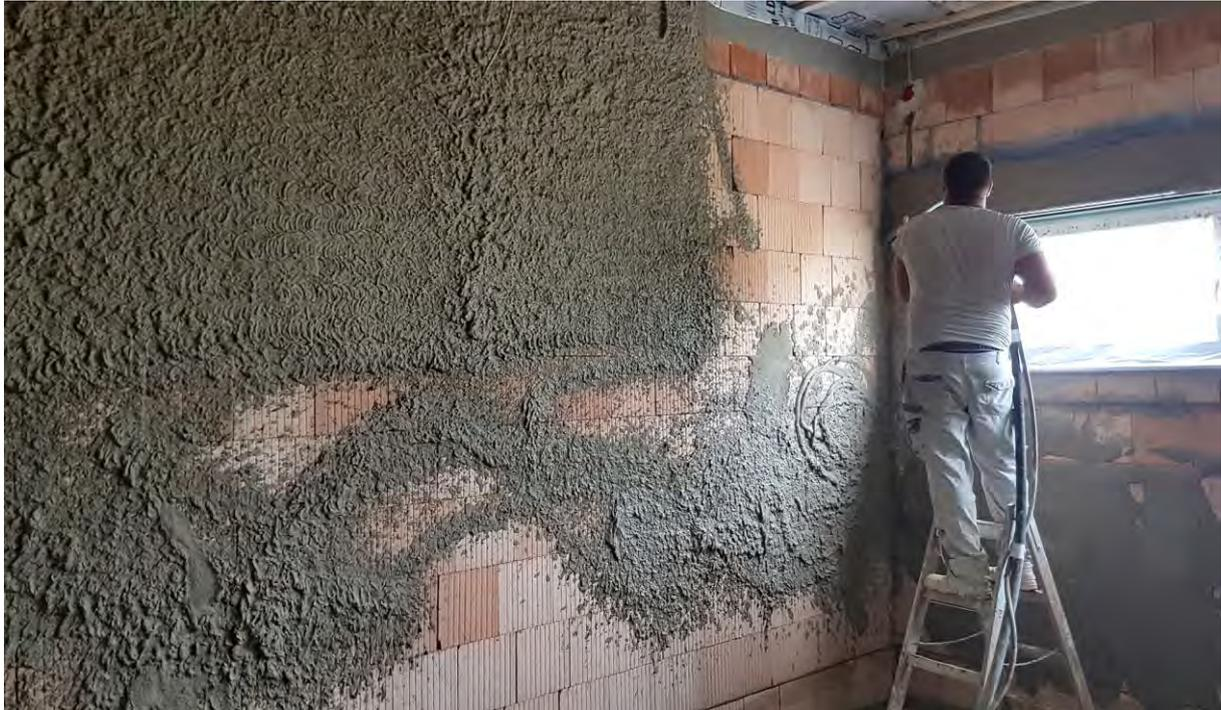
Foto: Mitte Juni folgte der Innenputz, der durch eine Fachfirma aufgebracht wurde
