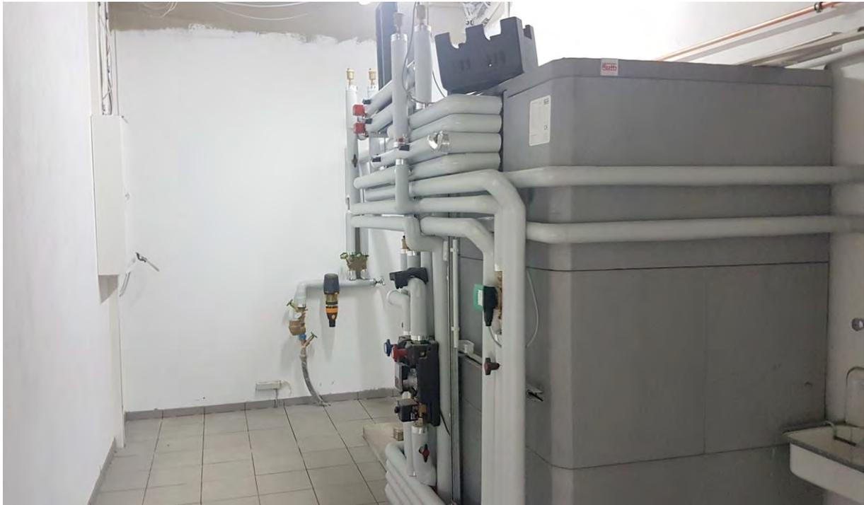
Foto: Auch die Heizungsrohre sind Mitte August isoliert, die Heizung läuft auf Hochtouren – und das im Sommer, da der Estrich aushärten muss
