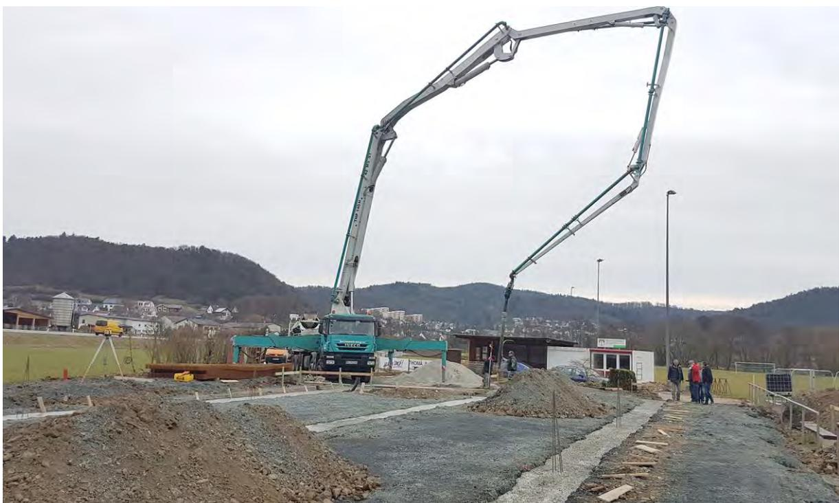
Foto: Nach den Vorarbeiten konnten am 15. März schon die Fundamente gegossen werden
