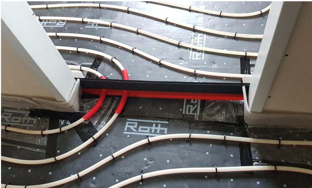
Foto: Die Rohre der Fußbodenheizung war Ende Juni fertig ferlegt
