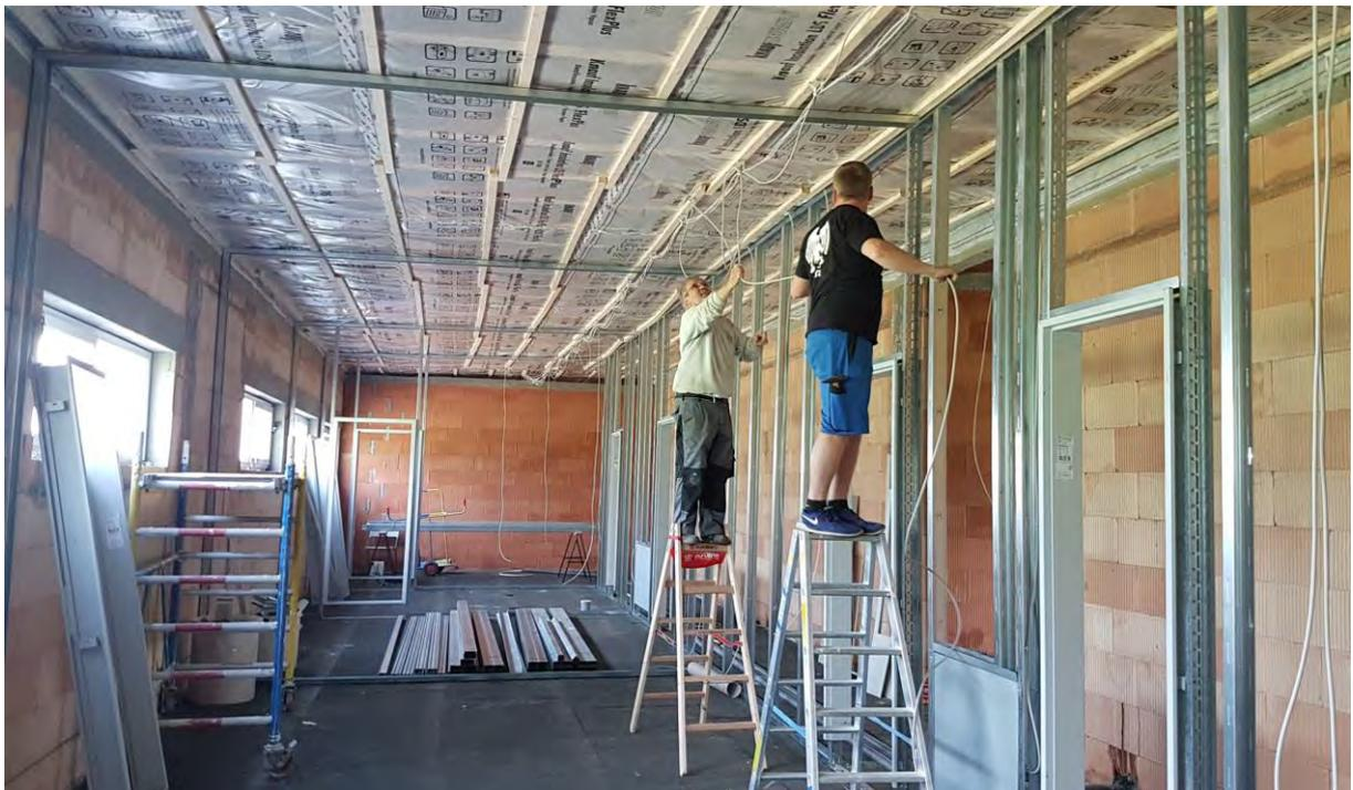
Foto: Der Innenausbau mit der Vorbereitung der Elektroinstallation und dem weiteren Trockenbau konnte folgen
