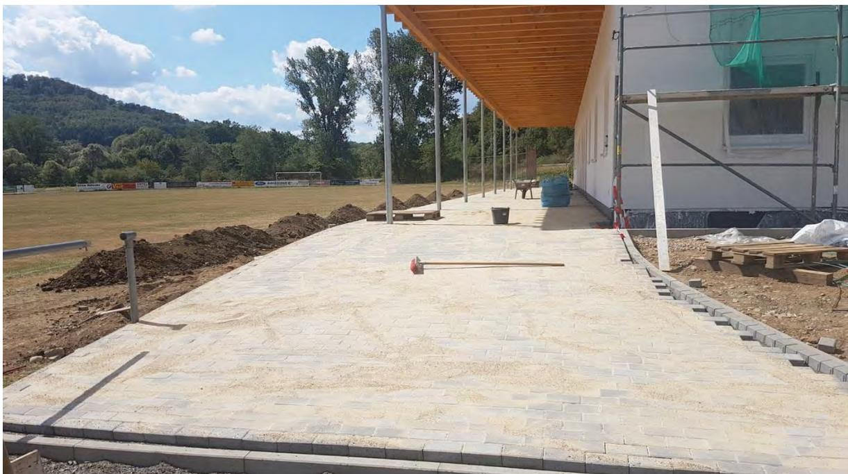
Foto: Sogleich wurde das Gerüst entfernt und mit den Pflasterarbeiten begonnen
